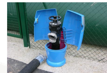
Poteau d'aspiration de 100 mm sur une réserve d'eau souple
