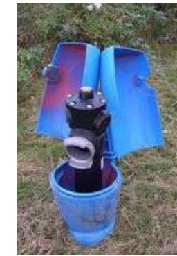
Poteaux d'aspiration de 100 mm à réseau sec, munis d'une seule sortie de 100 mm. Pas de volant ni de carré de manœuvre.
